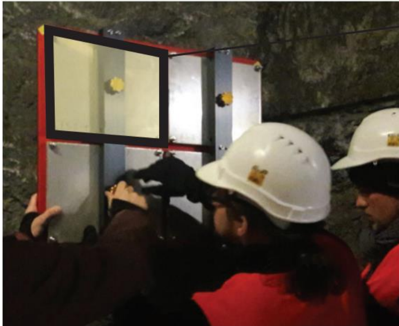
Montaje del detector en la pared del túnel ferroviario de Jungfrau
